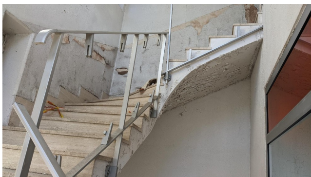
Escalier qui dessert l'étage
