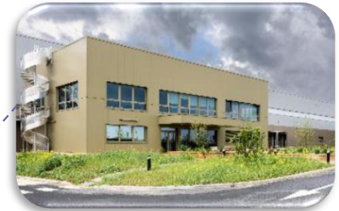
Bureaux clairs et terrasses végétalisées
