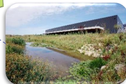
Bassins en gestion alternative des eaux pluviales
