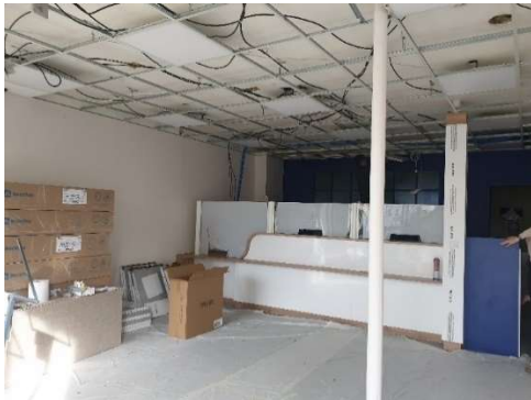
Fermeture temporaire de l'agence commerciale pour la réalisation des travaux
