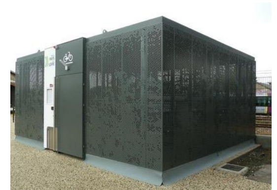
Abri vélo collectif fermé, Clisson
