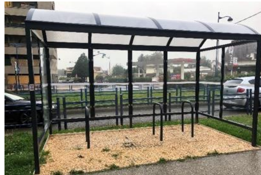
Abri collectif ouvert, Fosses
