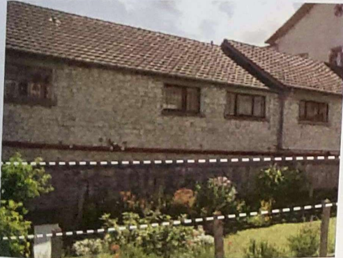
Muret de soutènement existant conservé et valorisé dans l'aménagement , pierre de tuffeau / tirer parti de l'existant
