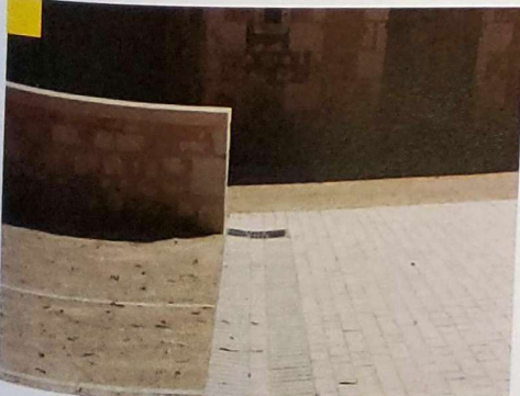
Sols - Transition béton désactivé cheminement stabilisé
