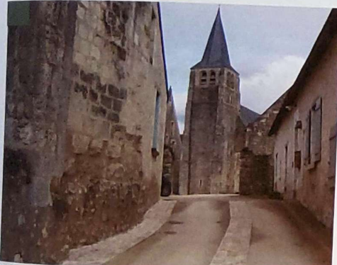
Voirie apaisée - Fils d'eau pavés, réduction visuelle et qualitative de l'emprise de la voirie
