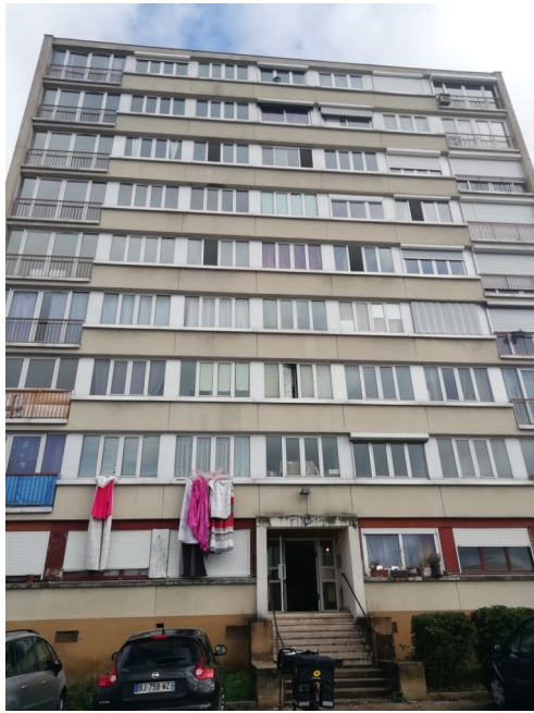
Façade de l'immeuble
