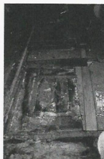
Figure 8 : salle des coffres forts, 2<sup>e</sup> sous-sol, panneaux de bois contaminés par des moisissures, NUM20161774
