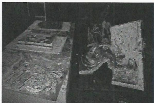
Figure 5 : salle des coffres forts, 2<sup>e</sup> sous-sol, plâtres souillés par les eaux sales, NUM20161773
