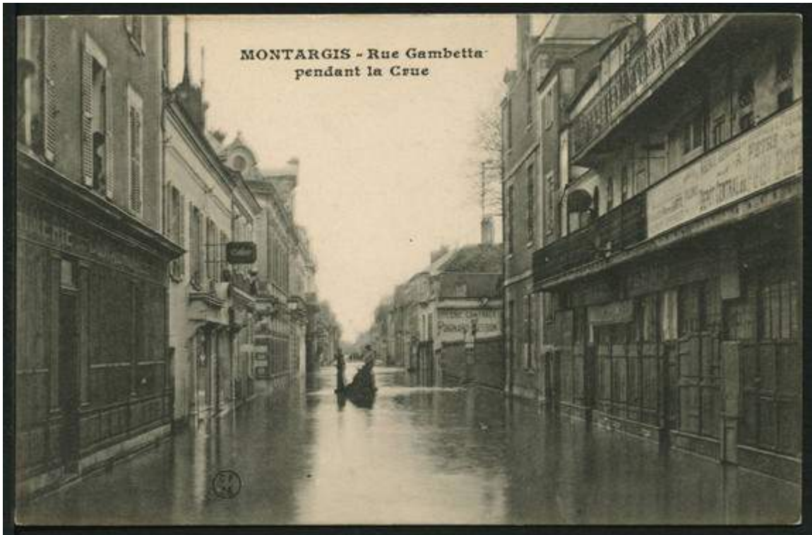
5 – Archives de la crue de janvier 1910 à Montargis – Source : inforisques.loiret.fr
