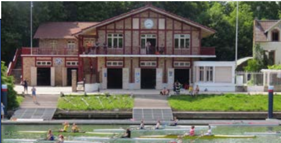
Club d'aviron de Joinville-le-Pont reconstruit à l'identique en 2007 suite à l'incendie du 24 octobre 2005
